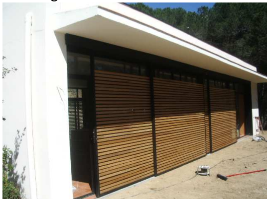
Argentona 2003/ habitatge unifamiliar
