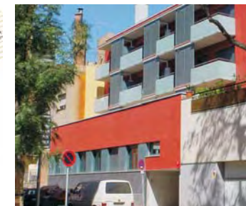
Proteção exterior: persianas de lamas reguláveis | Protección exterior: porticones de lamas orientables
