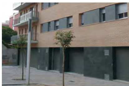
Tratamento fachada térreo com material resistente | Tratamiento fachada pl. baja con material resistente
