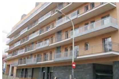
Tratamento fachada térreo com material resistente | Tratamiento fachada pl. baja con material resistente
