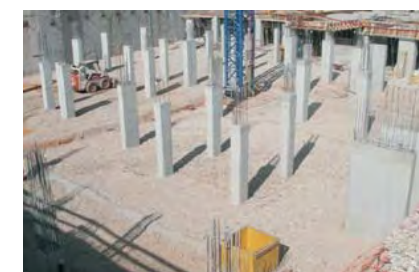
Soleira de cimentação de cascalhos ecológicos | Solera cimentación de ecogravas
