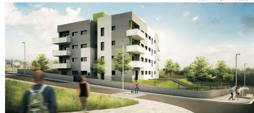
Painéis de concreto pré-fabricado na fachada | Paneles de hormigón prefabricado en fachada
