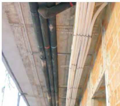
Instalações concentradas nas áreas comuns: otimização dos percursos + facilidade de manutenção | Instalaciones concentradas en zonas comunes: optimización de recorridos + facilidad de mantenimiento
