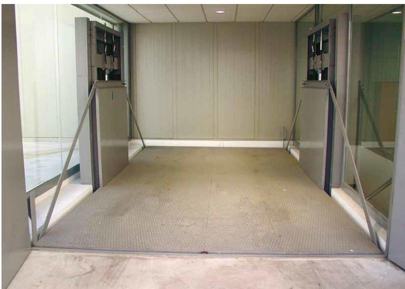
Son montacargas hidráulicos para el transporte vertical de cargas, diseñados para elevar hasta 10.000 kg (\*), para una amplia gama de dimensiones, recorridos y paradas.
