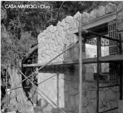
CASA MARROIG - Obra
