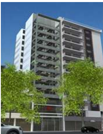
Edificio de viviendas Ubicación: Buenos Aires Colaboración con Estudio FFarqs. Año:2011
