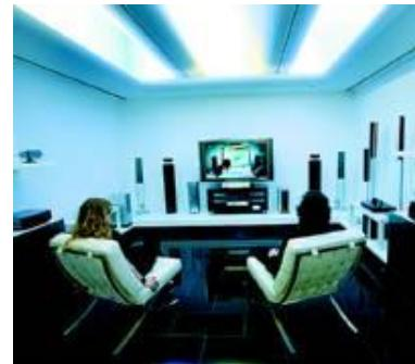
**Instalación realizada:** Sistema de iluminación mediante sistema DALI reproduciendo escenas espectaculares combinando diferentes colores de iluminación. Control del sistema mediante visualización y dependientes de programaciones horarias, otorgando gran flexibilidad antes cambios de decoración y a su vez siendo de fácil uso para los trabajadores.
