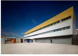
Centro de Educación Infantil y Primaria. Casar de Escalona. Toledo. 2007 Construido.
