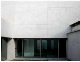
Vivienda unifamiliar. Palomeque. Toledo. 2003. Construido.
