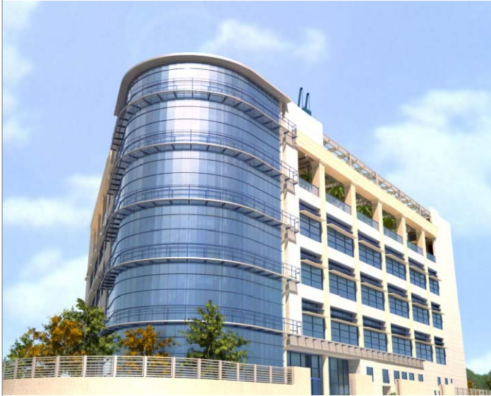
Edificio Tanatorio M-40. Avenida de los Rosales. Madrid
