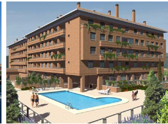
Conjunto residencial, C/ marques de Valdavia. Valdelasfuentes. Alcobendas. Madrid
