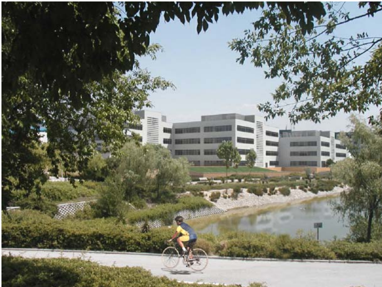
Edificio oficinas. P.P.Casablanca. Alcobendas. Madrid
