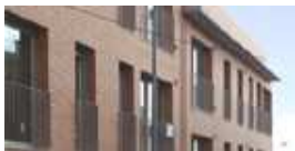
EDIFICI DE 17 HABITATGES I APARCAMENT AL CARRER NORD, 4 DE BELLPUIG. LLEIDA 2005 - 2007
