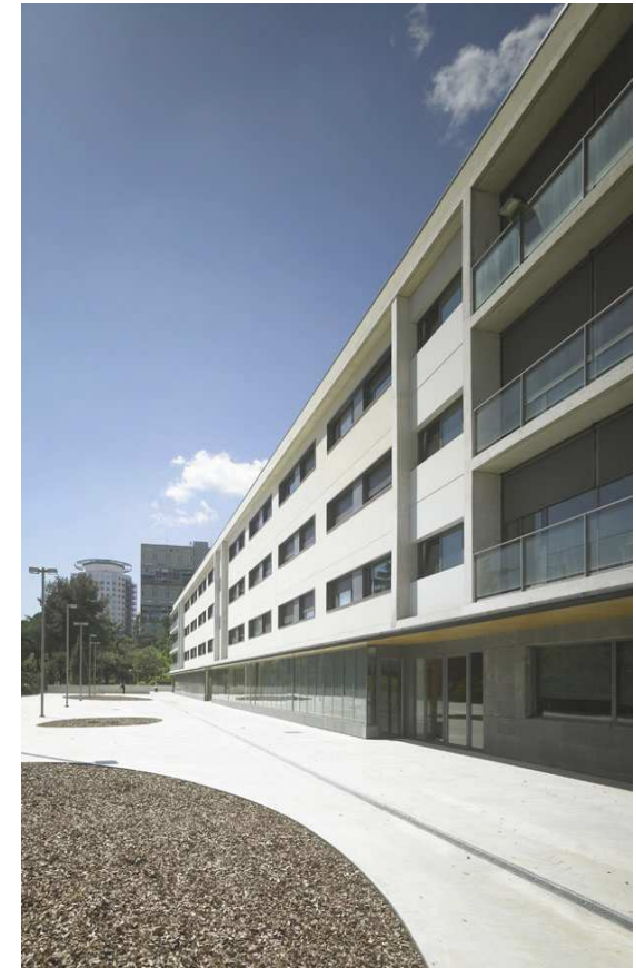
HOSPITAL-RESIDÈNCIA SANT JORDI. CAIXA CATALUNYA
