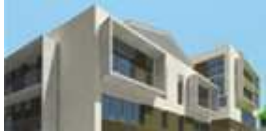
EDIFICI DE 32 HABITATGES LOCALS I APARCAMENT A SANT LLORENÇ D'HORTONS. 2009-...
