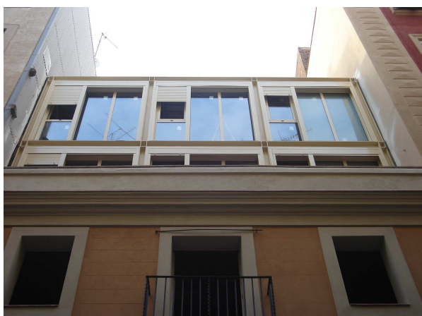
Adició 2 nivells edifici plurifamiliar Barcelona
