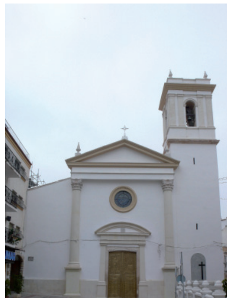
Fachada principal en ejecución
