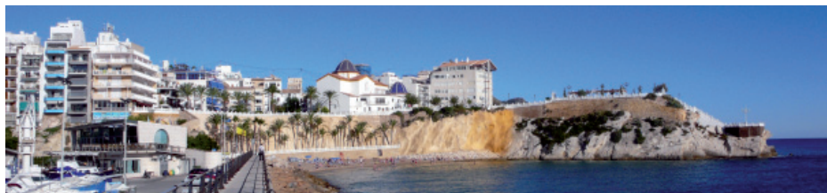
Vista del entorno de la Iglesia San Jaime Apóstol
