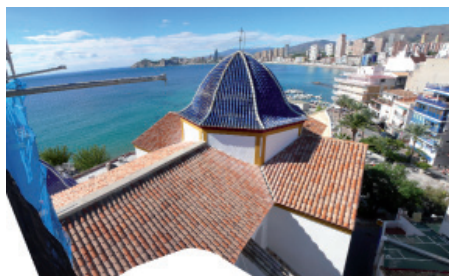
Vista de la cubierta y cúpula previa a la actuación
